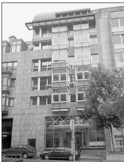
Gebäude der Generaldirektion SANCO (Gesundheit und Verbraucherschutz), Schauplatz der Sitzungen des CFR-net
