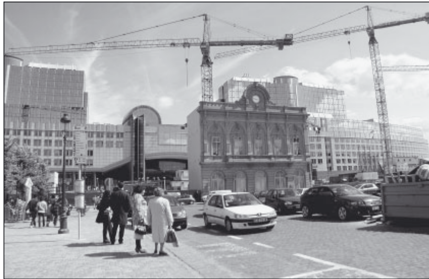
Baustelle Europa: Die Parlamentserweiterung in Brüssel
