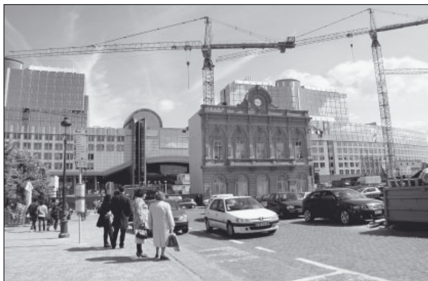
Baustelle Europa: Die Parlamentserweiterung in Brüssel
